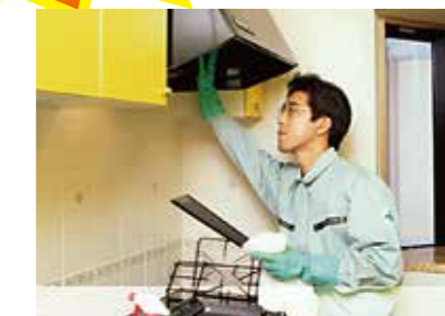
油で換気ができていません。そのため、洗浄によって、正常の回転になり、油が周辺にべっとりと付着しています。換気がスムーズになりました。
