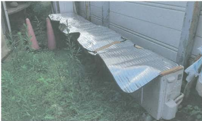
【室外機への日よけの設置】
