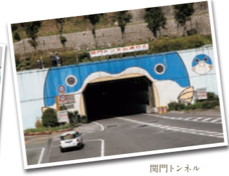
関門トンネル 450m (車で約2分)
