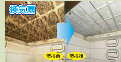
換気扇 フードの脱着、シロッコファンの脱着、換気扇の内部まで分解によりきれいに、フィルターは漬け置き洗い。 14,300円
